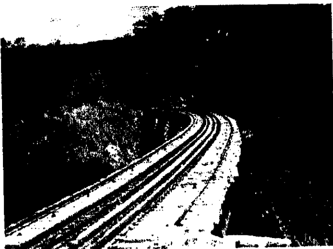
Puente El Tecolote, ya rehabilitado. Se cambiaron la totalidad de los durmientes. El Tecolote bridge already rehabilitated. All cross ties were changed.
