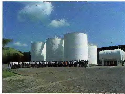
Tanques para almacenamiento de Látex
